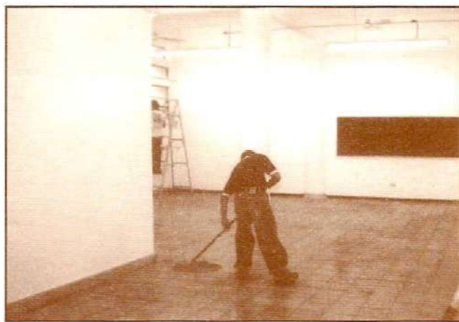
En la conclusión de los trabajos de habilitación. Foto AHUSON/aba.
